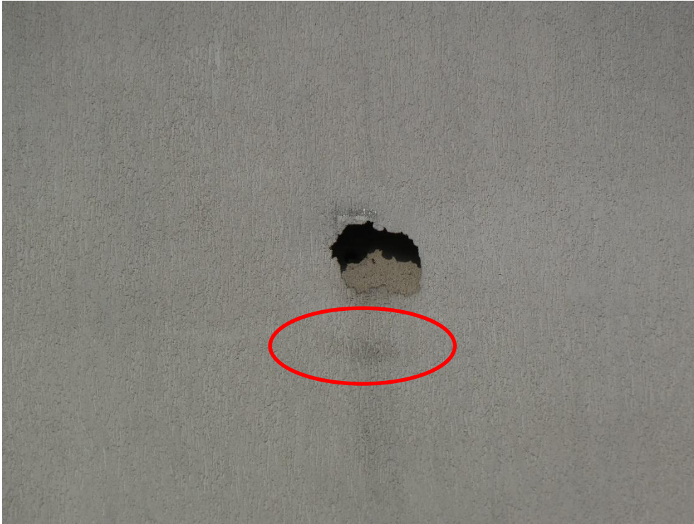
Fot. 3 Dziura w elewacji zasiedlona przez kawkę, widoczne charakterystyczne zabrudzenia; elewacja frontowa Budynku Głównego Szpitala (od ul. Wojska Polskiego)
