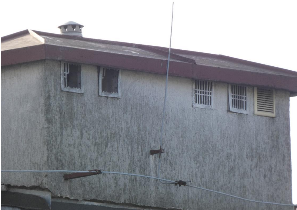
Fot. 4 Widok na kominy wentylacyjne Budynku Głównego Szpitala; zaznaczono wyłamane kratki wentylacyjne
