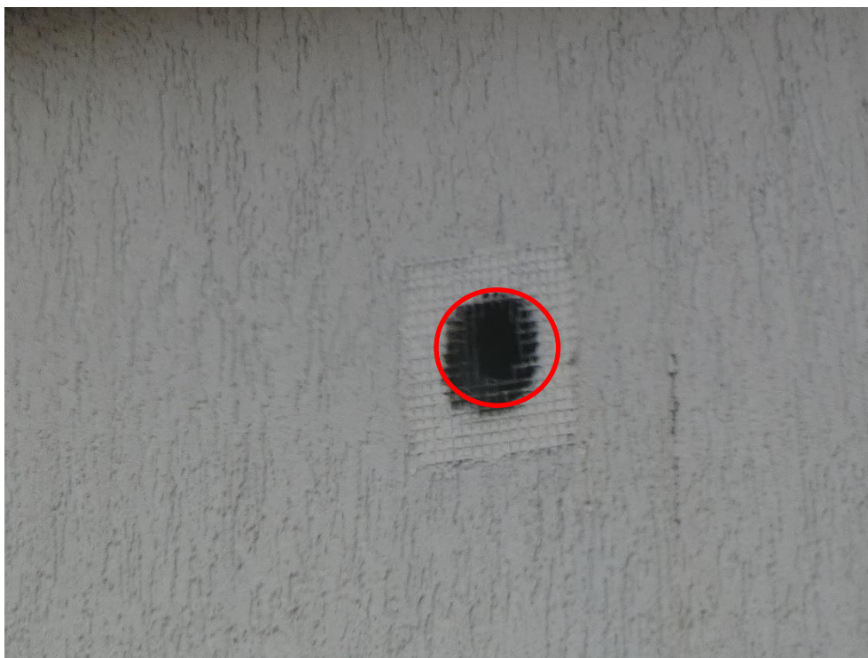
Fot. 2 Widoczna wydziobana dziura w kratce wentylacyjnej, elewacja północna Budynku Głównego Szpitala
