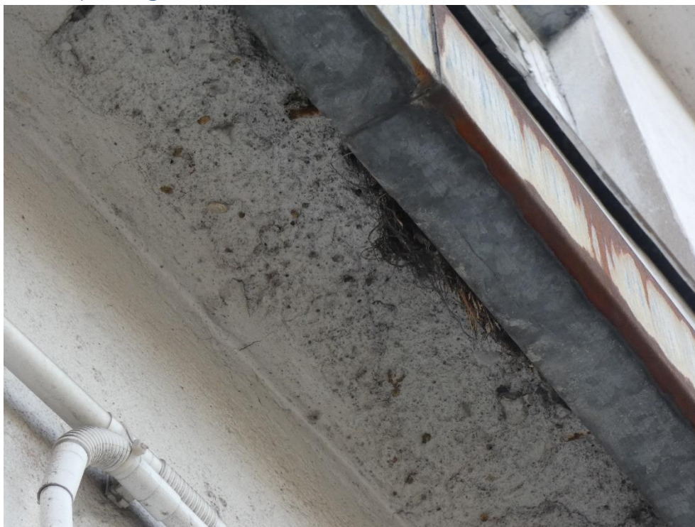
Fot. 1 Materiał gniazdowy wróbla w obróbkach blacharskich przy okapie dachu, budynek 5
